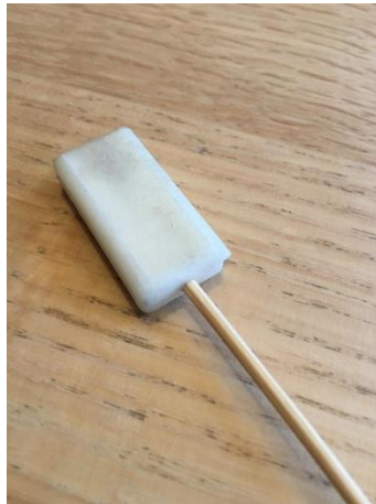
Afbeeldingen: Geboorde gaatje met een saté-prikker dichten en vervolgens glad afsnijden.
